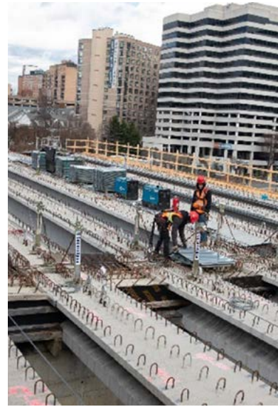
Arriba: El equipo de construcción instaló recientemente siete vigas de hormigón para el futuro puente sobre las vías del tren ligero para brindar acceso al centro comercial Glenridge en Landover Hills. Abajo: El equipo trabaja en la plataforma y la estación en el Centro de Tránsito Paul S. Sarbanes en Silver Spring.
