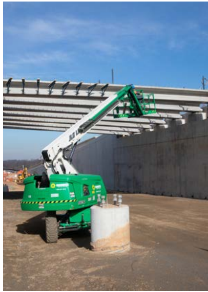
Arriba: El equipo de construcción instaló recientemente siete vigas de hormigón para el futuro puente sobre las vías del tren ligero para brindar acceso al centro comercial Glenridge en Landover Hills. Abajo: El equipo trabaja en la plataforma y la estación en el Centro de Tránsito Paul S. Sarbanes en Silver Spring.
