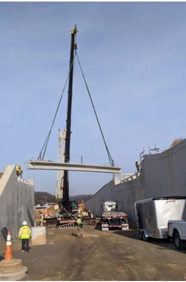
Arriba: El equipo de construcción instaló recientemente siete vigas de hormigón para el futuro puente sobre las vías del tren ligero para brindar acceso al centro comercial Glenridge en Landover Hills. Abajo: El equipo trabaja en la plataforma y la estación en el Centro de Tránsito Paul S. Sarbanes en Silver Spring.
