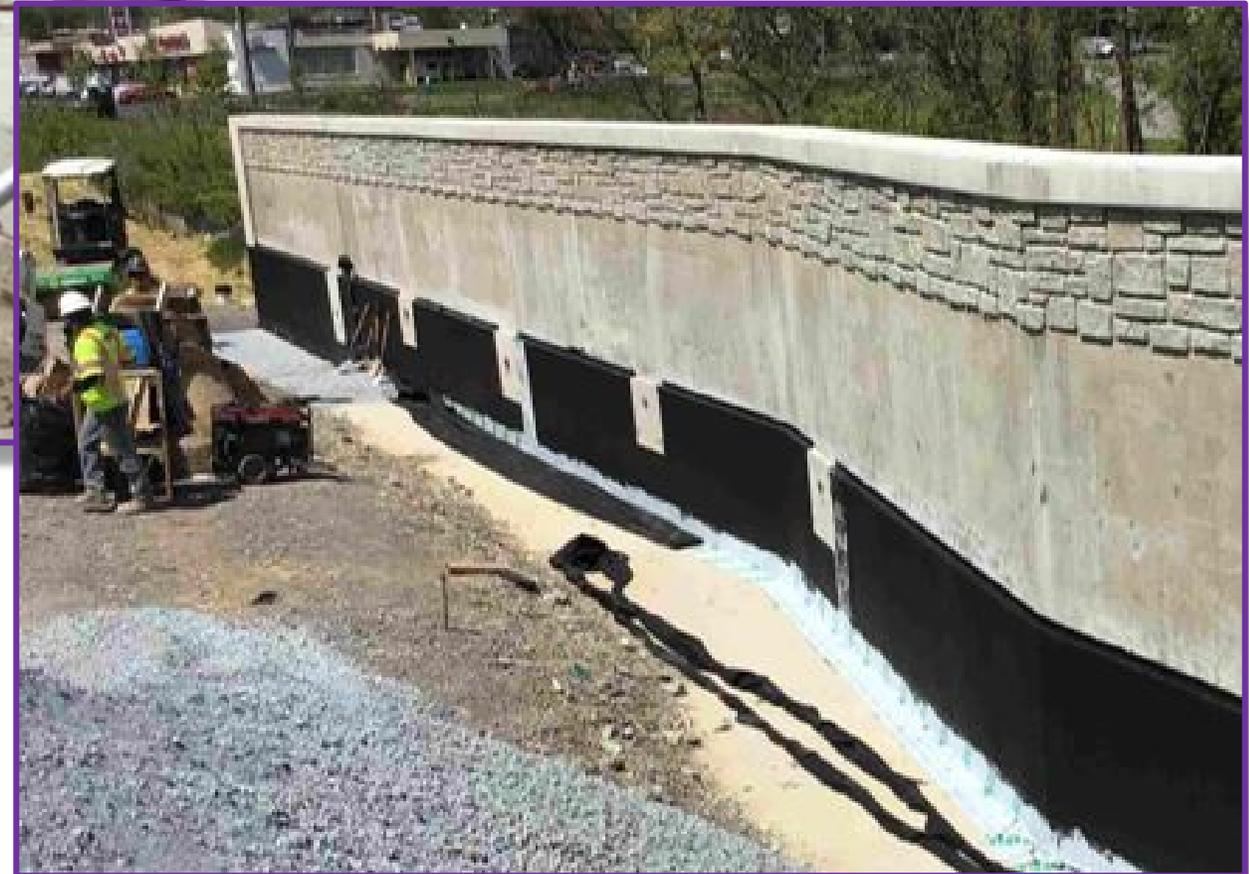
El vertido de la plataforma del puente Noroeste Branch se muestra en la imagen de arriba y la impermeabilización se muestra a la derecha.
