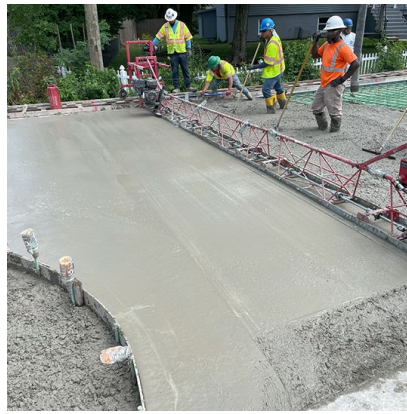
(Izquierda) Los equipos dan los toques finales al hormigón que sujeta la vía de fijación directa en el túnel de Plymouth. Con una longitud de 1,100 pies, es el único túnel de la Purple Line y albergará la estación Manchester Place en el portal occidental del túnel. (Derecha) Los equipos de construcción colocan concreto para la losa de acceso que conecta el puente de Talbot Avenue con Grace Church Road en Woodside. (Izquierda) Los equipos de construcción instalan un enorme filtro de arena como parte de las mejoras en la gestión de aguas pluviales en el campus de College Park de la Universidad de Maryland (UMD). (Derecha) La estructura subterránea está compuesta por cámaras de hormigón prefabricado que reducen las inundaciones ciclónicas y filtran la escorrentía a través de arena para eliminar los contaminantes que pueden impactar negativamente el sistema de arroyos locales.
