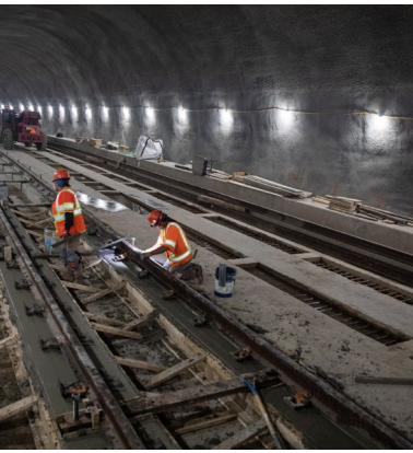
(Izquierda) Los equipos dan los toques finales al hormigón que sujeta la vía de fijación directa en el túnel de Plymouth. Con una longitud de 1,100 pies, es el único túnel de la Purple Line y albergará la estación Manchester Place en el portal occidental del túnel. (Derecha) Los equipos de construcción colocan concreto para la losa de acceso que conecta el puente de Talbot Avenue con Grace Church Road en Woodside. (Izquierda) Los equipos de construcción instalan un enorme filtro de arena como parte de las mejoras en la gestión de aguas pluviales en el campus de College Park de la Universidad de Maryland (UMD). (Derecha) La estructura subterránea está compuesta por cámaras de hormigón prefabricado que reducen las inundaciones ciclónicas y filtran la escorrentía a través de arena para eliminar los contaminantes que pueden impactar negativamente el sistema de arroyos locales.
